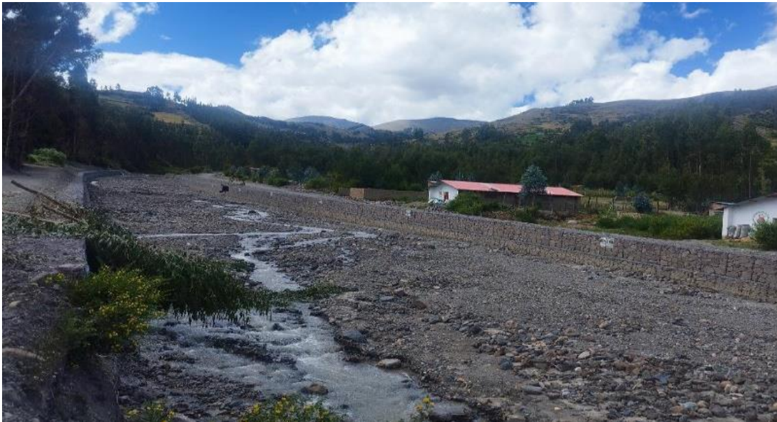
FIGURA N° 02: SE APRECIA EN LA IMAGEN LA EXISTENCIA DE GAVIONES AMBAS MARGEENS EN EL TRAMO EN LA QUEBRADA S/N (RIO MAYUPAMPA) DEL DISTRITO DE PITUMARCA.
